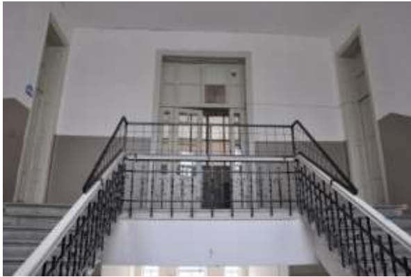
Resim 16. Merdivenin ara sahanlığından birinci kata bakış
