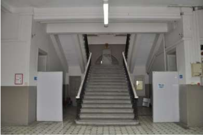
Resim 3. Zemin kat, merdivenin yer aldığı bölüm, girişten görünüş
