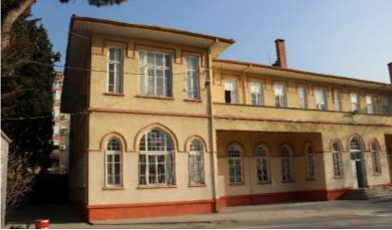
Resim 25. Karşıyaka İmam Hatip Ortaokulu, güney cephe, batı bölümü
