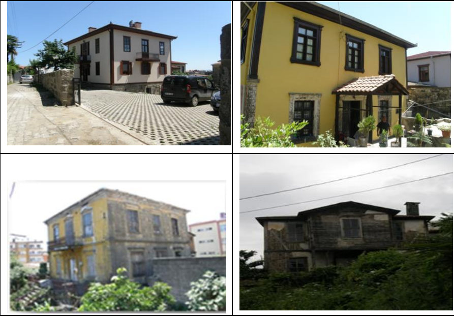
Şekil 11. Mahalle içindeki restore edilmiş ve edilmemiş evler
