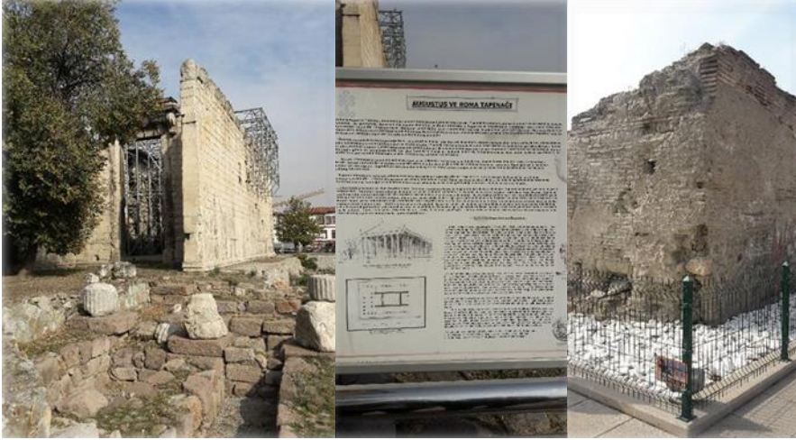
Şekil 20-21-22. Augustus Tapınağı Çevresinde Kültürel Peyzaj Öğeleri (8-9-10) (Solda Augustus Mabedi ve Tanıtım Panosu – Sağda Bakımsız Terk Edilmiş Osmanlı Hamam Kalıntısı) (Fotoğraflar: AYTEKİN, Ö.)
