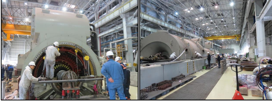
Fotoğraf 5: Eren Enerji’de türbin bakım işlerinde çalışan Çinli personelden birer görünüm
