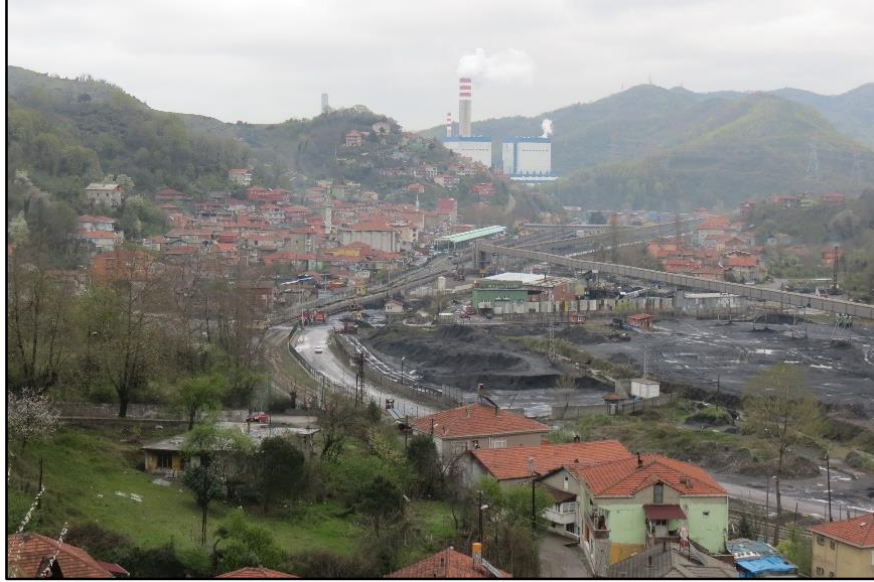
Fotoğraf 1: Çatalağzı Kasabası ve Eren Enerji Termik Santrali'nden bir görünüm
