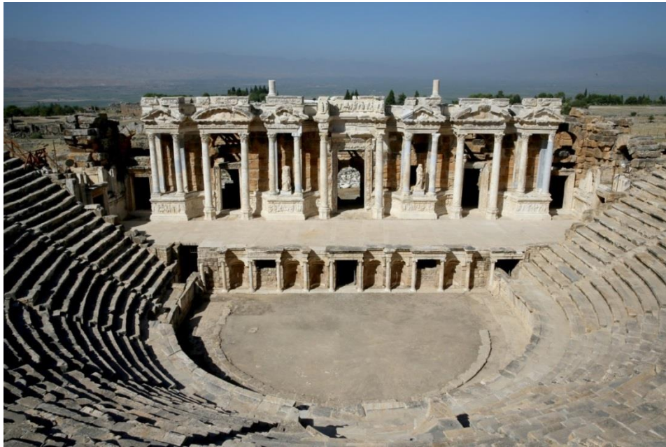
Fig. 11: Hierapolis. Tiyatro, 2013 yılında tamamlanan restorasyon çalışmalarından sonra sahne binası
