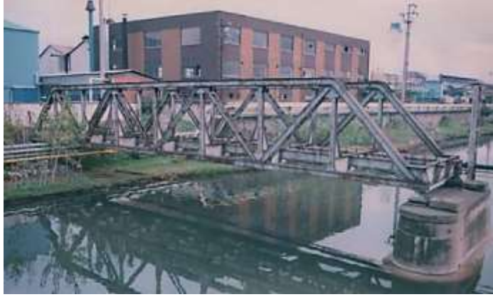
Şekil. 5. Diliskelesi (perçinli demiryolu) köprüsü Figure 5. Diliskelesi (riveted railway) Bridge
