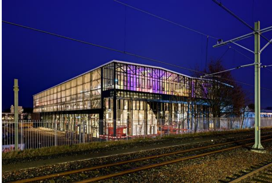
Şekil 12. LocHal Kütüphanesi, Gece Dış Cephe Görüntüsü (Archello,)
