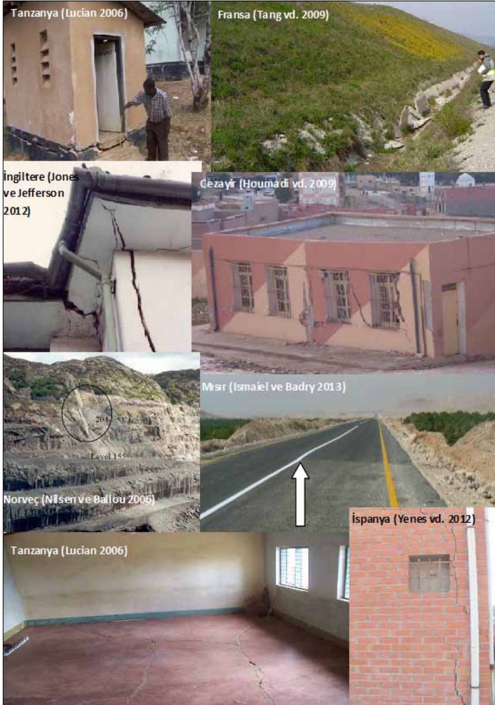
Şekil 13. Çeşitli ülkelerde zemin ve kayalardaki hafif yapılarda oluşan şişme problemleri.
