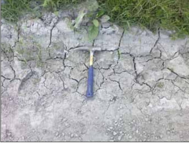
Şekil 5. Muslu yöresinde büzülmeyle oluşmuş kuruma çatlakları.
