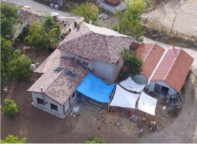
Şekil 12. Ahırın yaşam mekânına dönüşümden çatı penceresi çözümü (Köyünü Yaşat Projesi Fotoğraf Arşivi)
