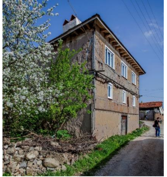
Şekil 4. Yapıların özgün ahşap doğrama pencereleri onarım esnasında pvc doğrama pencerelerle değiştirilmesi (Ergand, 2015)
