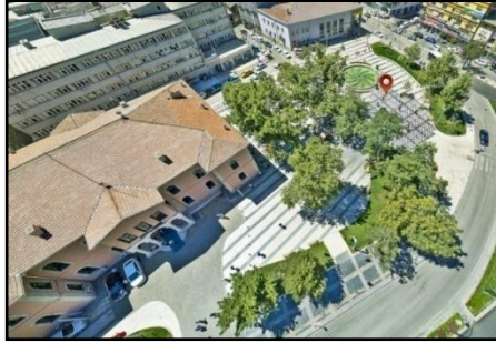
Şekil 7. İzzetpaşa Meydanı Kuş Bakışı Görünümü(Elazığ Bel., 2016)
