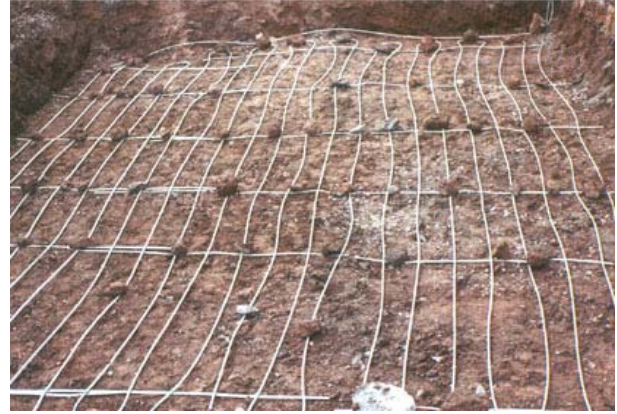
řekil 4. Boruların toprak altına yerleřim planı.
