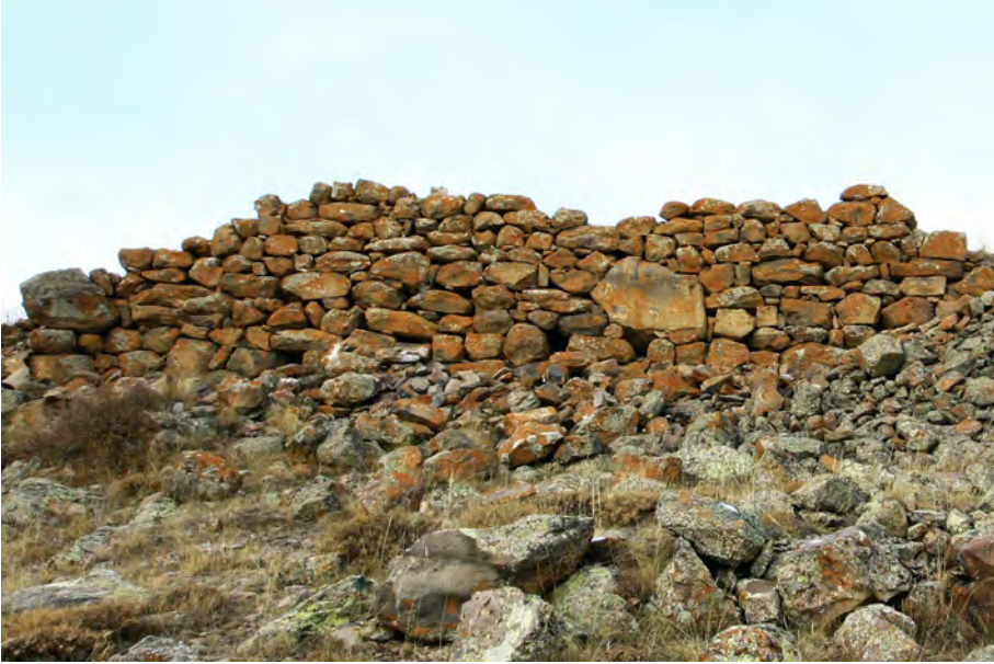
Foto. 4: Kapıkaya Kalesinde Farklı Büyüklükteki Taşların Bir Arada Kullanıldığı Sur Duvarı.
