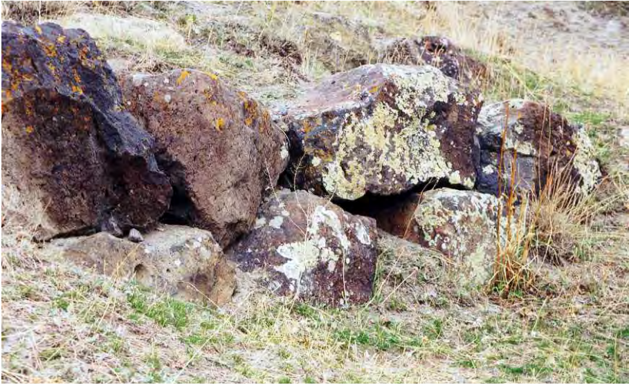
Foto. 6: Uzunahmet Kalesi Sur Duvarlarından Bir Bölüm.
