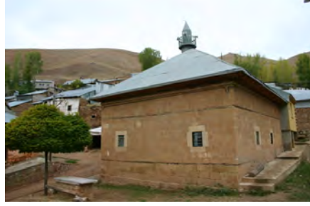
Foto. 2: Caminin güneydođu cephesi.
