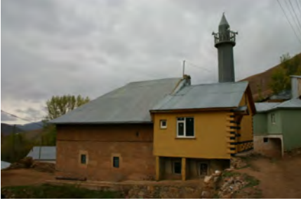
Foto. 1: Caminin dođu cephesi.
