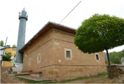
Foto. 3: Caminin güneybatı cephesi.
