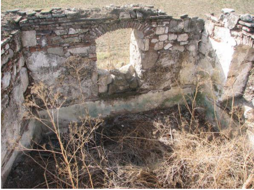
F 12 – Türbenin iç mekanın fiili durumu
