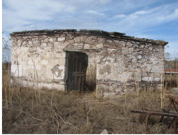
F4- Türbenin giriş cephesi
