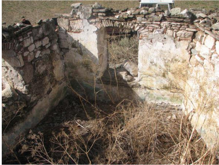
F2- Türbenin pencereli beden duvarları
