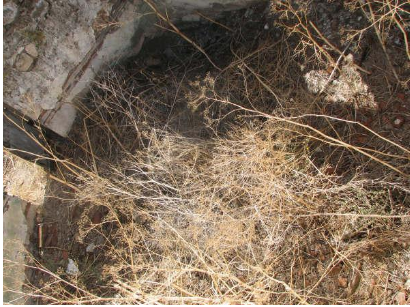
F 13 - Türbenin iç mekanın fiili durumu
