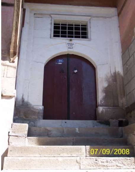
Foto 12: Cepheden İe ekilen Yarım Daire Formlu Giriş
