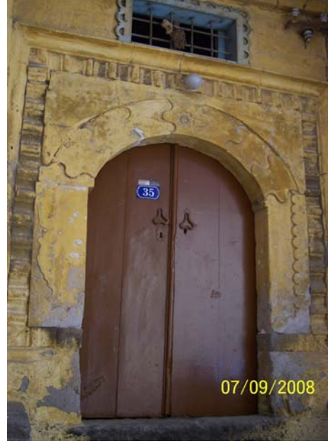
Foto 13: Cepheden İe ekilen Yarım Daire Formlu Giriş
