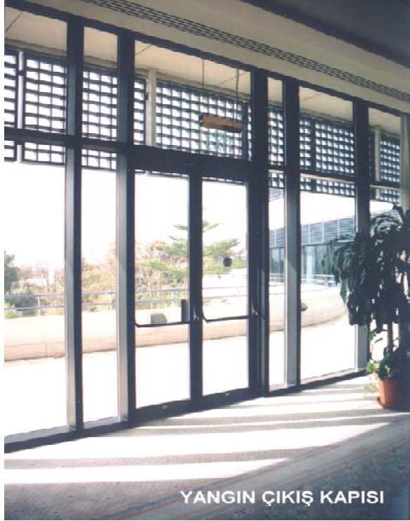
Resim 3. Holden teras açılan yangın kapıları
