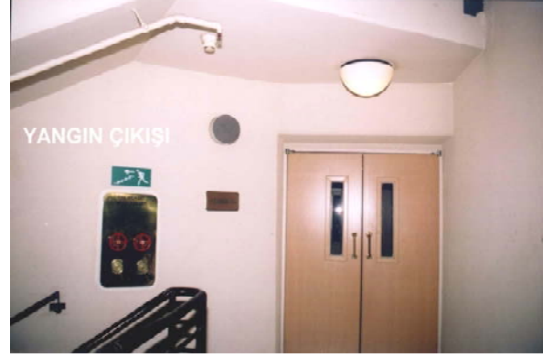
Resim 2. Yangın merdiveninin içten görünümü
