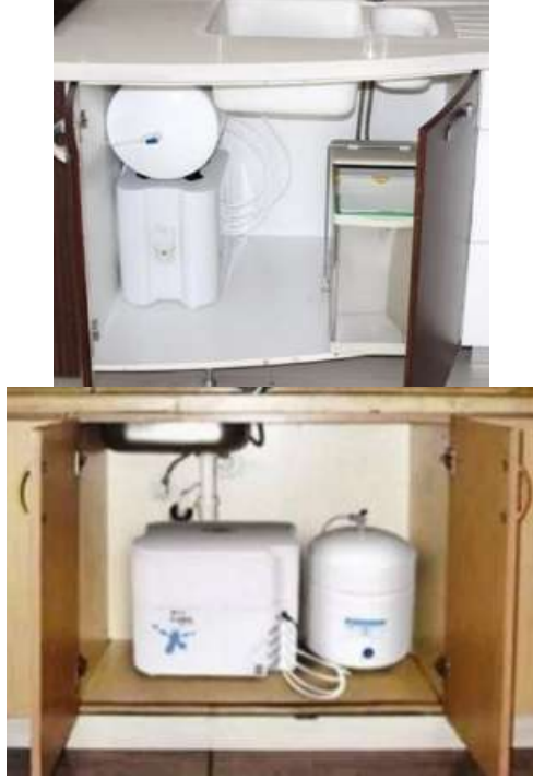
Şekil 5. Su arıtma cihazı evye altına yerleşim durumu ( Settlement condition under water purifier sink ) [26]
