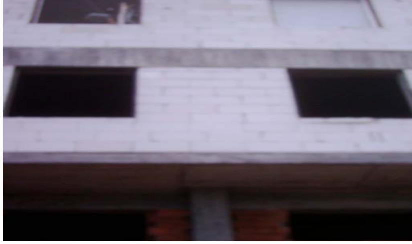
Şekil 2. Gazbetonla yapılan dış duvar uygulaması.
