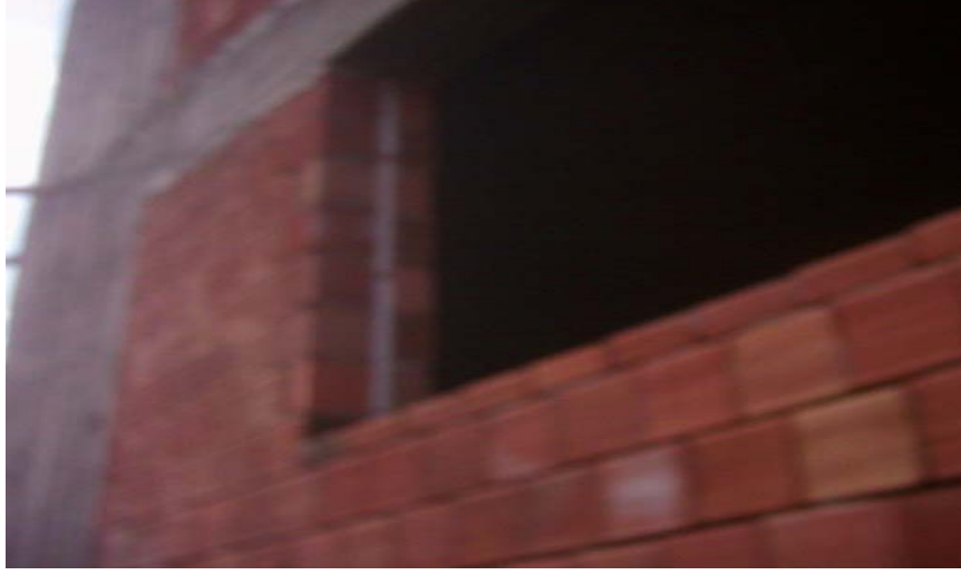
Şekil 5. Sandviç duvar uygulaması.
