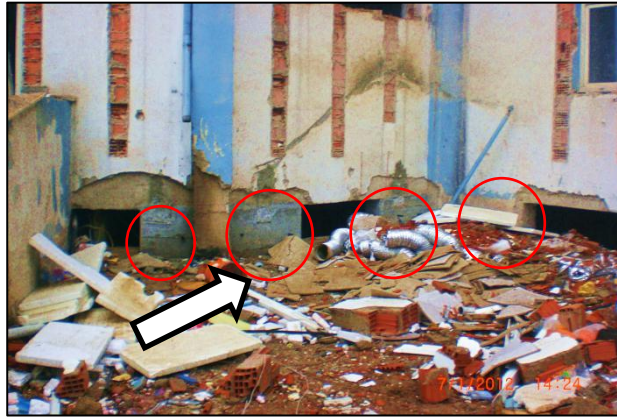
Şekil 10. Bant pencerelerin daraltılmış hali
