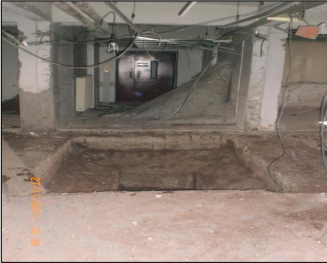
Şekil 8. Temel çukuru açılması ve temellerde yapılan güçlendirme çalışmaları
