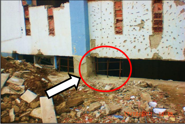
Şekil 9. Bant pencerelerin daraltma çalışması
