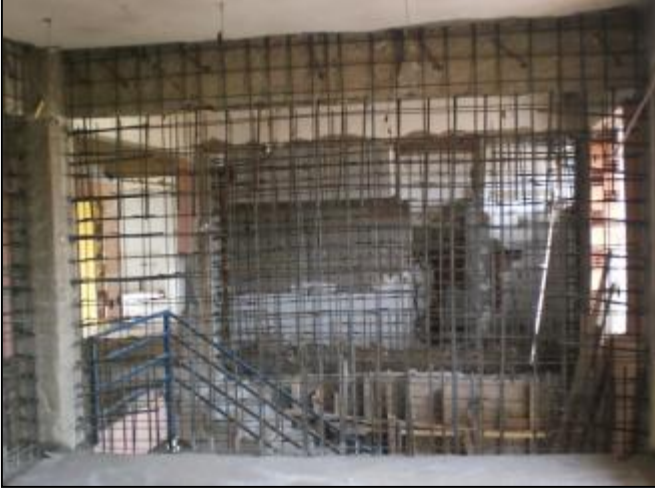
Şekil 7. Örnek perde donatı açılım detayı
