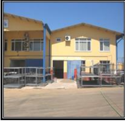
Fotoğraf 5. Altınova Mahallesinde ihracata yönelik kesme çiçek üretimi yapan bir işletmenin soğuk hava depoları (Fotoğraf S. Zaman)
