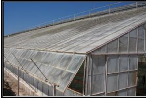
Fotoğraf 2. Yüzeyi kireç ile sıvanmış bir çiçek serası (Fotoğraf-S.Zaman).
