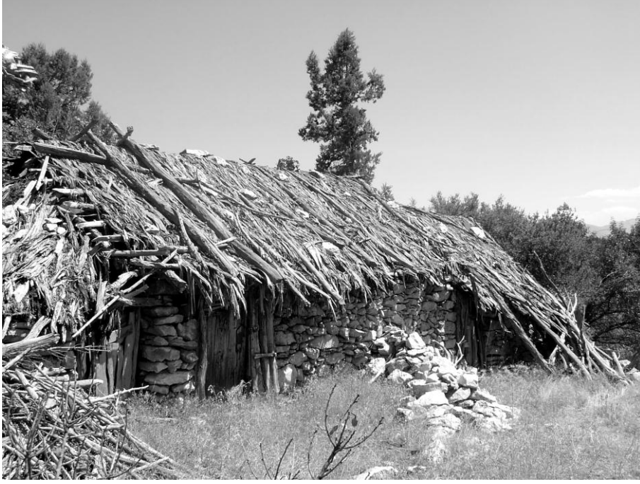
Fotoğraf 3. Seki Yaylalarında “Kabuk Ev” Denilen Taş Meskenlerden Bir Görünüş.
