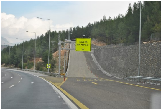
Şekil 1. Tarsus-Pozantı otoyolundaki 1 nolu kaçış rampasının genel görünümü
