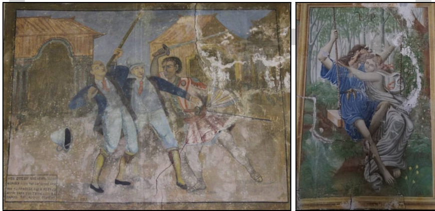
Resim 9. Sıva Tabakasında Görülen Çatlak ve Ayrışma Örnekleri, Mustafapaşa, (Kişisel Arşiv, 2021)
