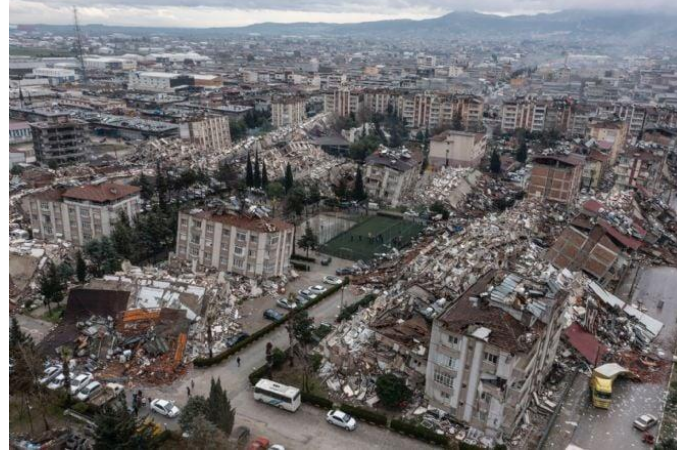
Şekil 5. Hatay / Antakya'da Depremde Yıkılan Rönesans Rezidans ve Çevresi.
