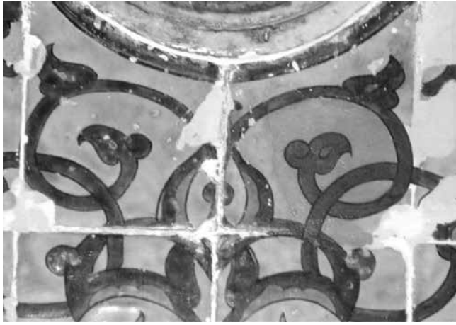
Resim 2: Çini tabakta kireç atması. Kaynak: İzmir Konak Yalı Camii Çinilerinden Detay.
