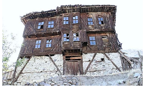
Resim 4. Bozyer Köyü/Zemin (Ahır) + 2 Katlı Ev Örneği
