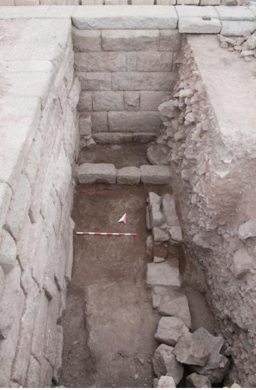
Fig. 3: Skene binası orta odasında tespit edilen konutun sıkıştırılmış toprak zemini ve duvarları.
