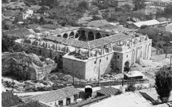
Fotoğraf 20: 1954 yılı onarımı, alaturka kiremit döşemesi (Üsküp Kültürel Anıtlar Koruma Enstitüsü Arşivi)
