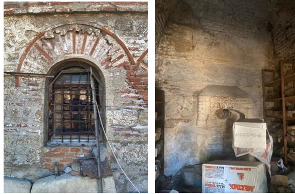
Fotoğraf 24: a) Malzemedeki bozulmalar b) Çiçeklenme ve çatlaklar
