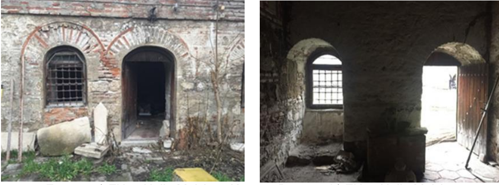
Fot. 10: a) ZK38 No'lu Mekânın Kapı ve Pencere b) ZK38 No'lu Mekânı
