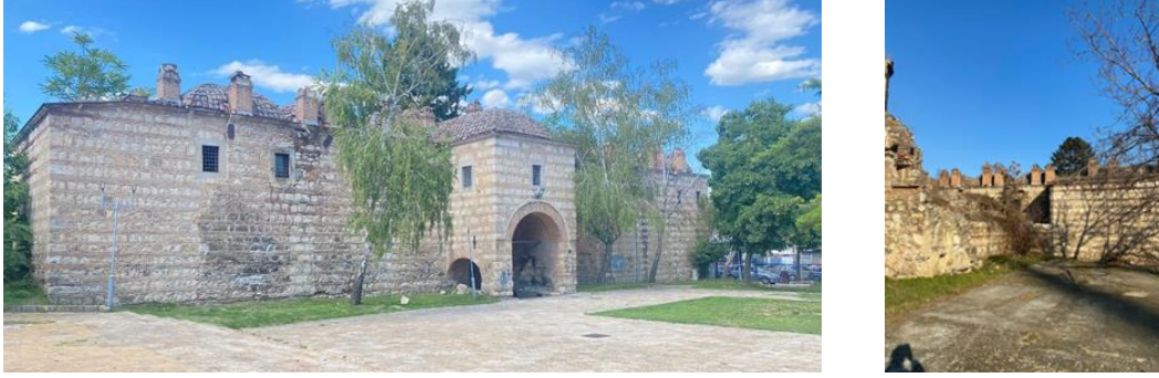
Fotoğraf 13: a) Hanın Güney Cephesi b) Hanın Batı Cephesi
