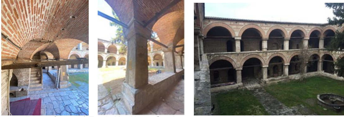
Fotoğraf 16: a-b) Zemin Kat Ahşap Gergi
