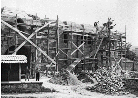
e) Ana Giriş Bölümünün Onarım Çalışmaları
