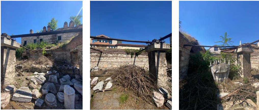
Fotoğraf 23: Üst Örtüsü Çöken Doğu Kolu
