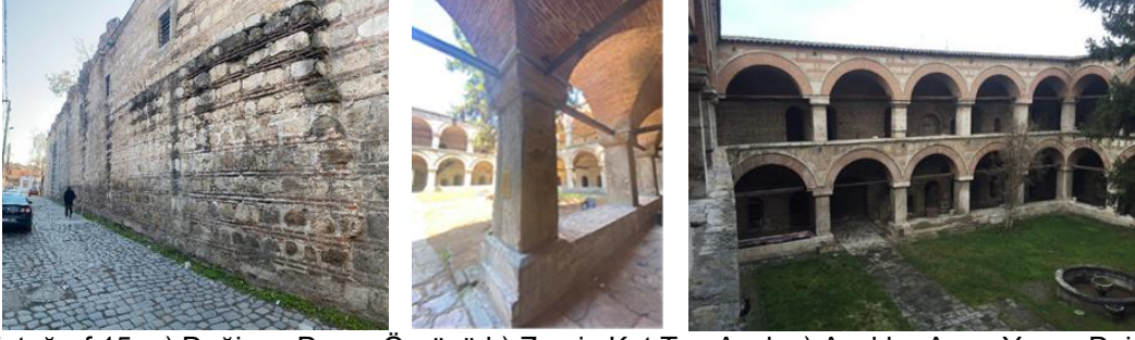
Fotoğraf 15: a) Değişen Duvar Örgüsü b) Zemin Kat Taş Ayak c) Ayaklar Arası Yarım Daire Kemerler
