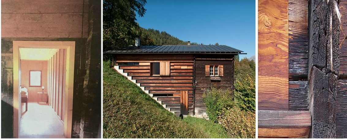
Resim 7. Solda, Gugalun evi içinde eski-yeni eşiği. Ortada, yeni kütle ile eski kulübenin teması (Bilgin, 2015). Sağda, işlenmemiş yeni kerestenin eski malzeme ile buluşması (URL-7).
