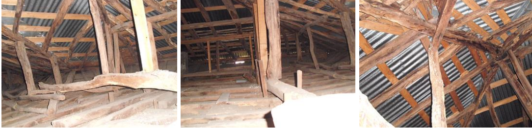
Fotoğraf 11: Ahşap oturtma çatı düzeni (M. Ataman)
