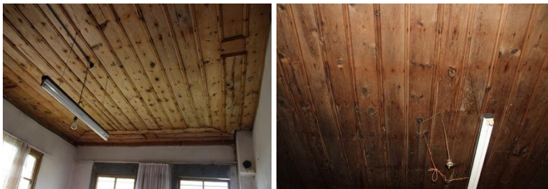
Fotoğraf 5: Tek sıralı çıtalı ahşap tavan (M. Ataman)
