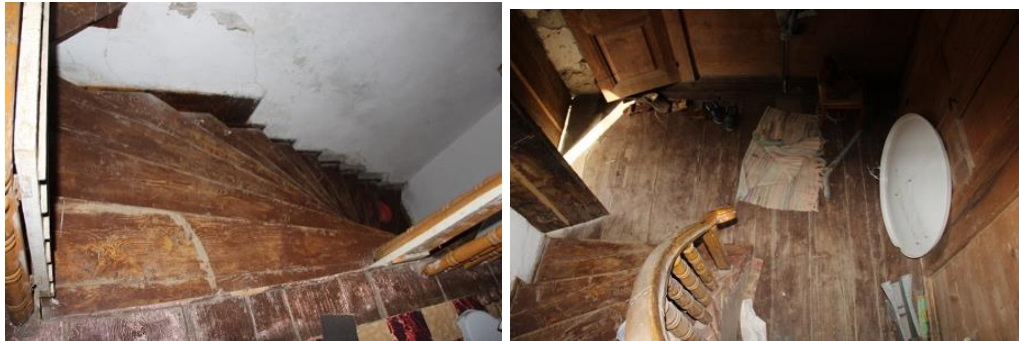
Fotoğraf 9: Ahşap dönerli merdiven (M. Ataman)
