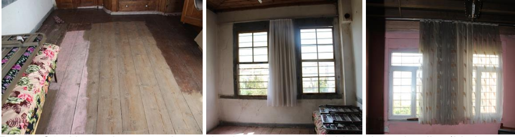
Fotoğraf 6: Ahşap döşeme, ahşap giyotin pencere ve alt hiza ahşap hatıllar (M. Ataman)
