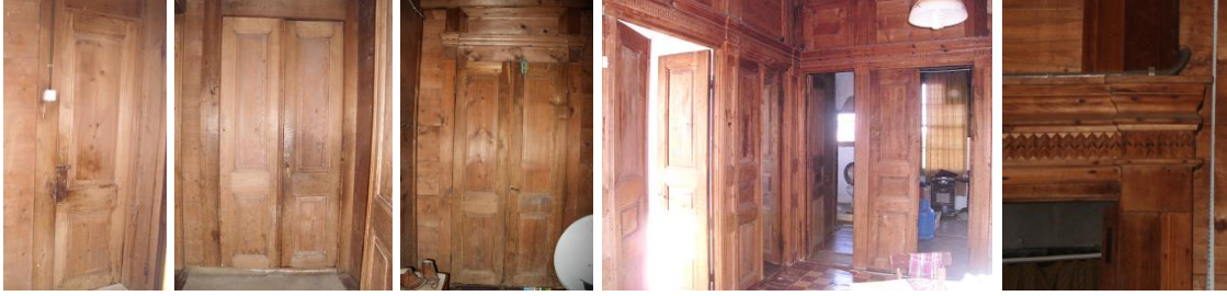
Fotoğraf 7: Tek-çift kanatlı zemin kat oda kapıları ve sofaya açılan üst kat oda kapıları (M. Ataman)
