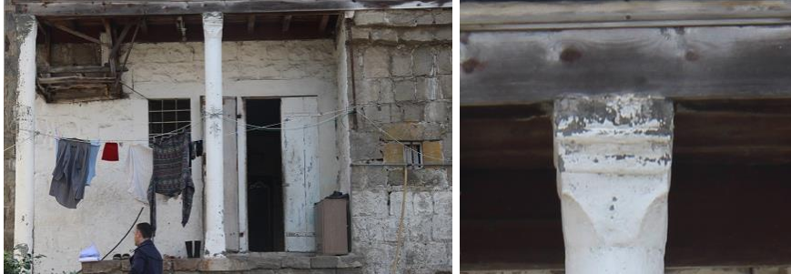
Fotoğraf 15: Taş sütunlar ve başlık detayı (M. Ataman)
