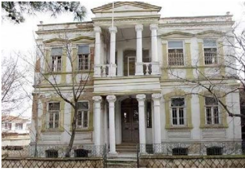
Şekil 2 Eski Vali Konağı'na ait fotoğraflar a) (URL-2),
