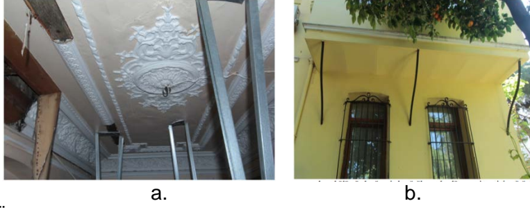
Şekil 18. a. Özgün kapının açıldığı mahaldeki tavan süslemesi b. Bahçe cephesine bakan çıkmanın özgün volta döşemesi (İlke Ciritçi)
