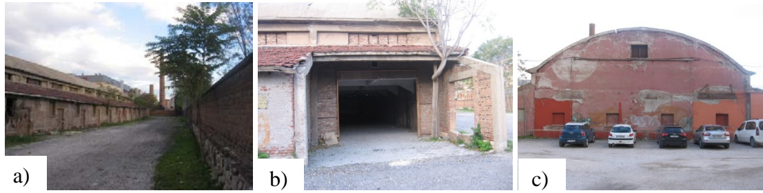
Şekil 16. a) Çiftkurt Kiremit Fabrikası güney cephesi, b) Çiftkurt Kiremit Fabrikasının halen açık olan güney cephesi servis girişi, c) Çiftkurt Kiremit Fabrikası batı cephesi [14].
