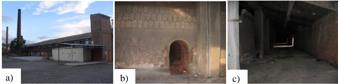
Şekil 17. a) Çiftkurt Kiremit Fabrikası kuzey cephesi ve tuvalet eklentisi, b) Çiftkurt Kiremit Fabrikası fırına giriş kemeri, c) Çiftkurt Kiremit Fabrikası kuzey cephesi tarafı iç mekan koridor görünümü [14].
