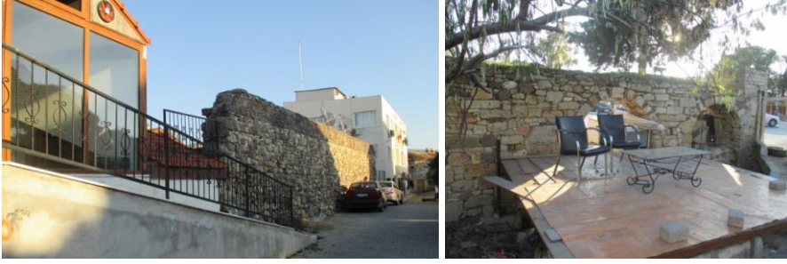
Şekil 10. a) Osmanlı dönemi ticaret hayatının mekânsal yansıması olarak tuz depolarından kalan tek duvar b) Osmanlı dönemi su kemerlerinin günümüzdeki durumu (Taşcı, 2015)
