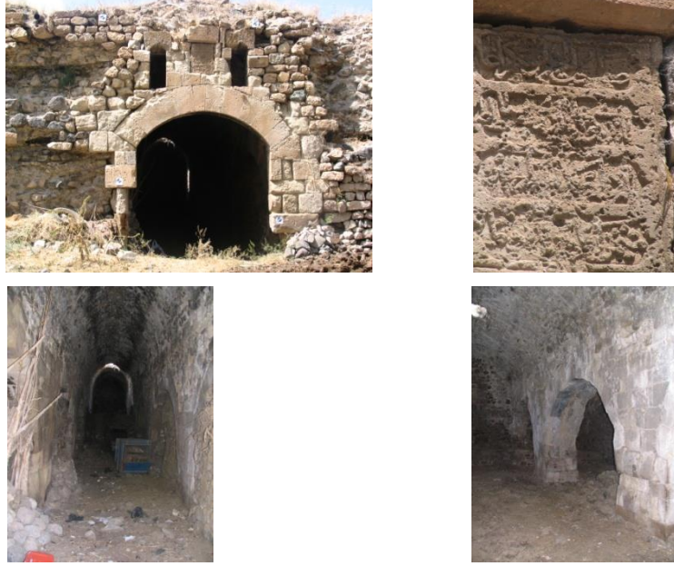
Şekil 3. Cephe ve İç Mekân Fotoğrafları 12
