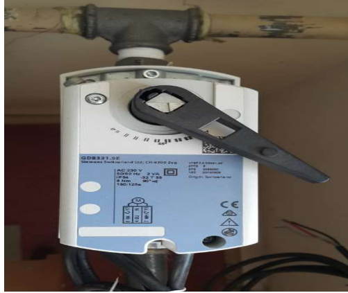
Şekil 2. Aç – Kapa (Yüzer) Oransal Vana
