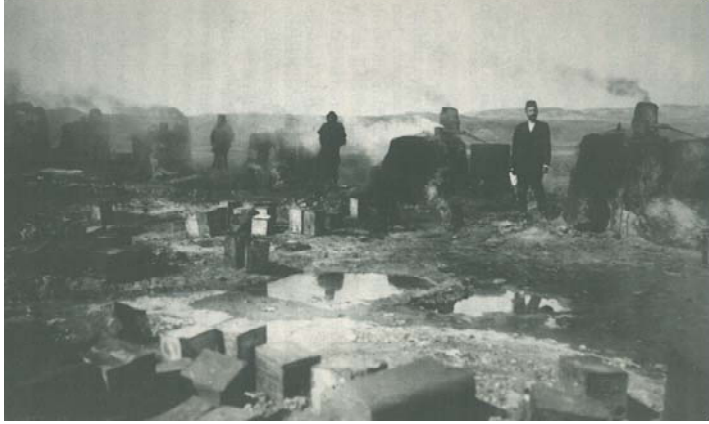
Resim 3. Musul vilayeti Kayyare Petrol Tasfiyesi Şirkat Arıtma Tesisi
