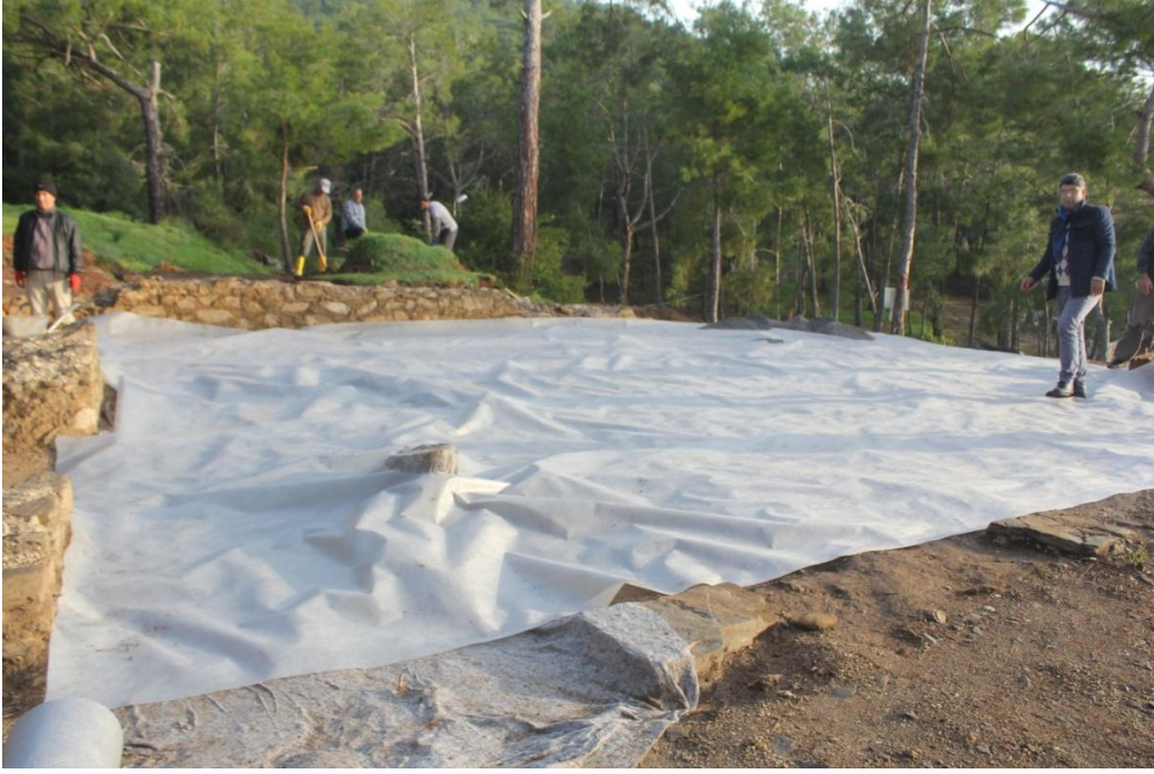
Fig.5: Naos kısmının jeotekstil malzeme ile örtülmesi.
