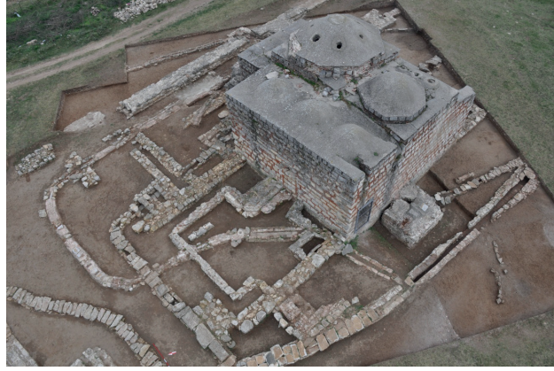
Res.4: Kum Kasrı Hamamı, kazı sonrası görünüşü (ESK Arşivi).
