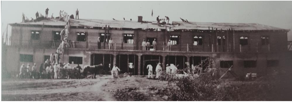
EK-30. Merkez bina çatısının imeceyle birlikte inşası (Aydoğan, 2015)
