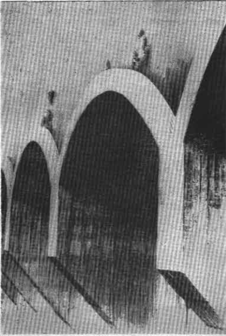
Resim 11. Güney Afrika Cumhuriyeti'nde inşa edilmiş çok sayılı kavşılı silt tutucu bir bent (N, Hudson, Soil Conservation, S:225).
