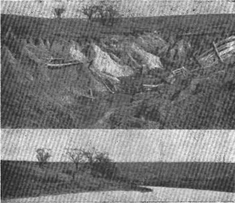
Resim 1. Üstte, Missouri'de, kapasitesinin üzerinde otlatılmış bir mer'ada teşekkül etmiş bir oyuntu. Altta, aynı oyuntu ıslah edilmiş ve çiftlik göletine bağlanmıştır (Soil Conservation Service, H.H. Bennett, Soil Conservation, S: 508).
