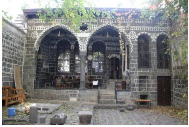
Foto 5: Eyvan Türleri (Dabanoğlu Mah. 175 ada 5 parsel)
