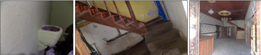
Foto 8. Zemin kat yapı elamanları-taşlık; saka çanağı örneği: Fikri Evin Evi (1887), merdiven örneği: Yaşar İkizler Evi (19. yy. sonları), hela örneği: Müceldili Konağı (1901).
