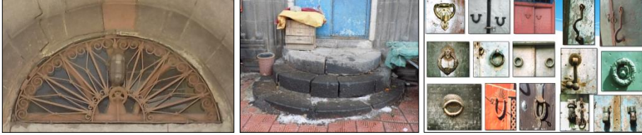
Foto 16. Geleneksel Erzurum evleri kapı detayları: Kullebilerin Evi (1909) ay-yıldızlı kapı üstü tepe penceresi demir şebekesi, Hacı Kemal Gürler Evi (20. yy. başları) kapı sınır oval taş merdiveni ve kapı taktak örnekleri.
