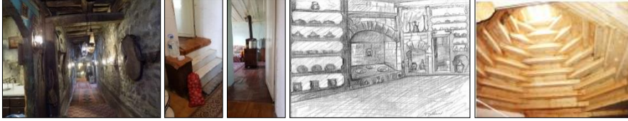
Foto 9. Zemin kat yapı elemanları-geçiş holü; Erzurum Evleri (19. yy. sonu), harem odası örneği: Sıra Evler (19. yy. sonu), Edip Somunoğlu Evi (1875) tandirevi çizimi(Köşklü), kırlangıç örtü örneği: Atatürk Üniversitesi Erzurum Evi (2006).
