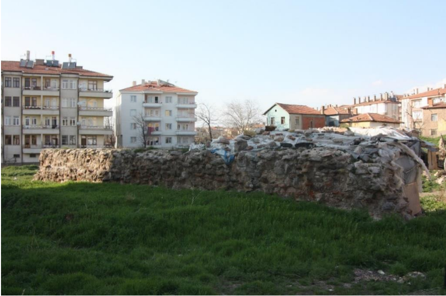
Tımarhane'den Günümüze Ulaşan Duvar Kalıntısı
