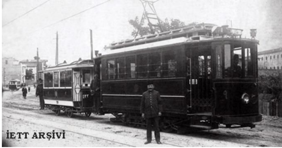
Görsel 2. Elektrikli Tramvay
