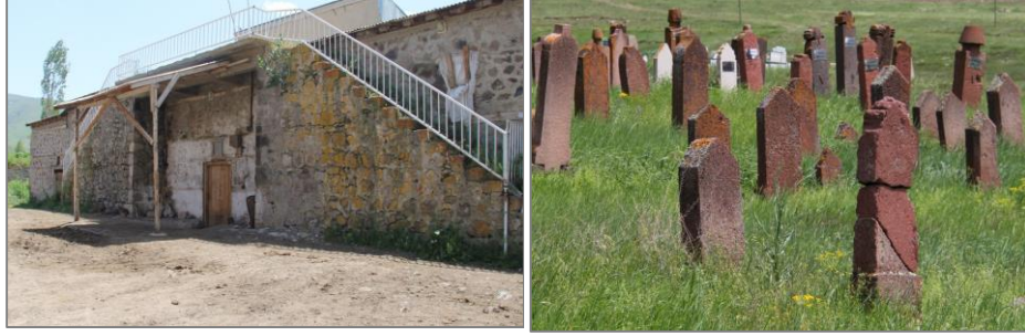
Fotoğraf 6. Kesme taş, sahadaki geleneksel yapı unsurlarındadır.
