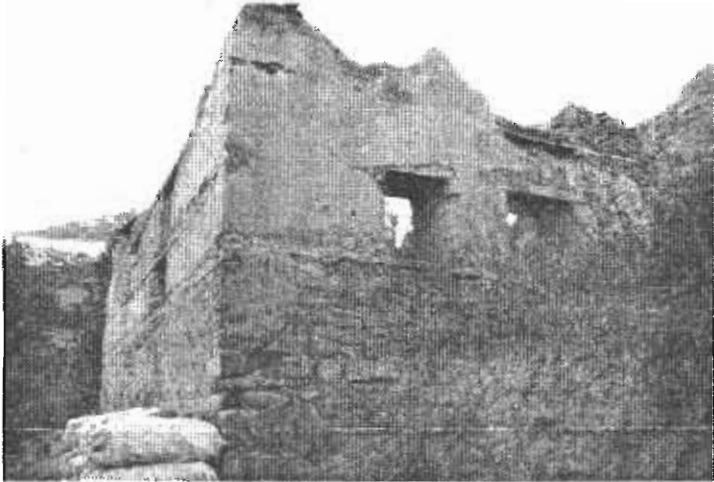
Resim 23: Güzeller Mahallesi Camii
