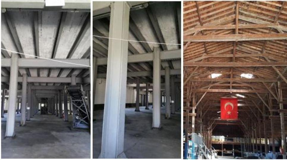
Şekil 5. Üretim ve Ambar Binasının iç görünümü (yazarlar arşivi,, 2016)
