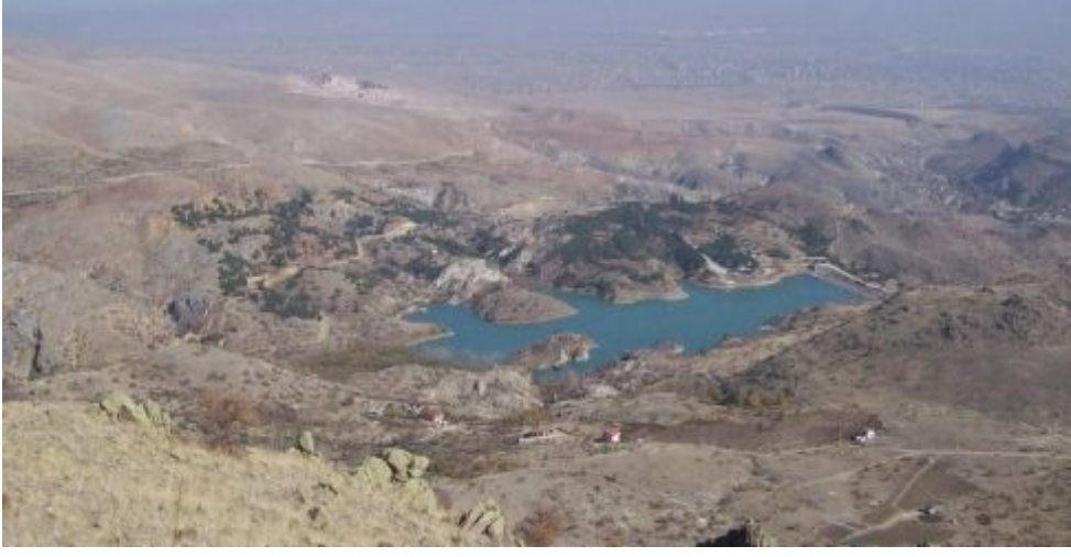
Foto 8. Sille Barajı Çevresinde Su Erozyonuna Uğramış Sahalar
