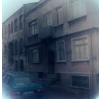
Şekil 2. Dönüşüm öncesinde parsellerdeki binaların görünüşü, solda tarihi (sonradan tescil edilen) bina, sağda harap durumda ancak tarihi olmayan bina.
